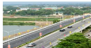
Hình ảnh 6: Cầu vượt đường sắt Cầu vượt đường sắt Vinh - Nghệ An (2014)
