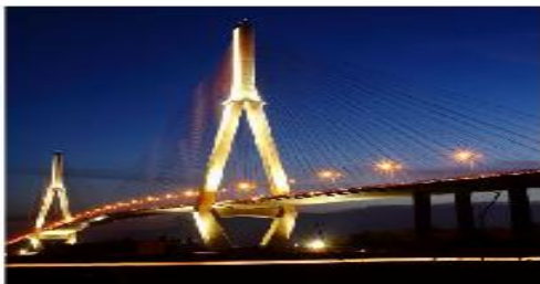
Hình ảnh 9: Cầu Cần Thơ Gói thầu P1- cầu dẫn phía Vĩnh Long thuộc dự án cầu Cần thơ (2005-2009)
