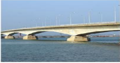
Hình ảnh 7: Cầu Sông Gianh Cầu bắc qua Sông Gianh - Quảng bình Ninh đúc hẫng 120m
