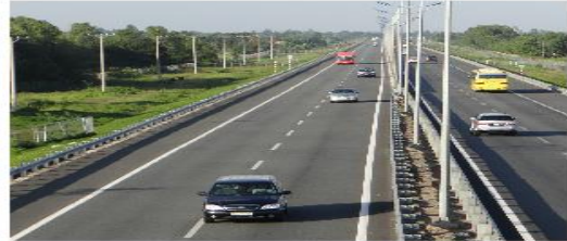
Hình ảnh 2: Cao tốc Tp. Hồ Chí Minh - Trung Lương. Thi công các đường và cầu trên tuyến (2005-2008)
