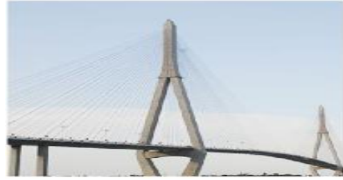
Hình ảnh 8: Dự án Cầu dây văng Thác Giề Cầu dây văng tại Bắc kạn do Thăng long tự thiết kế và thi công (2001)
