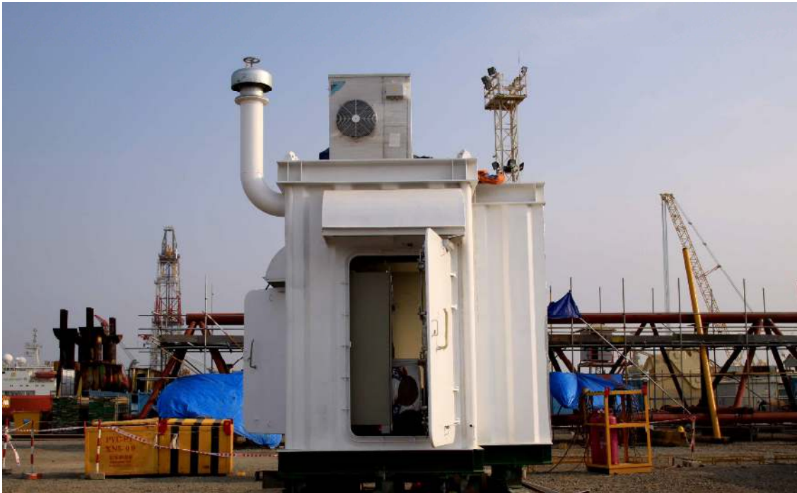
(Lắp đặt và hoàn thiện Phòng UPS & Battery cho XN Xây lắp, Khảo sát và Sửa chữa - VSP)
