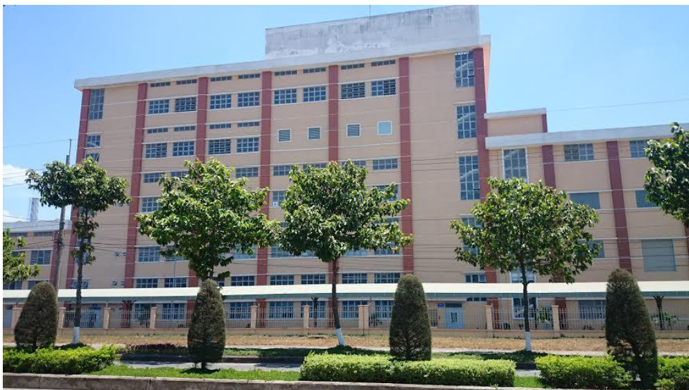
Mảng xanh, sạch, đẹp tại Nhà máy Long Thành.
