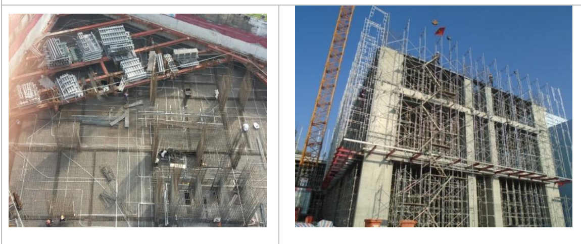
Thi công phần thân dự án D-Vela
