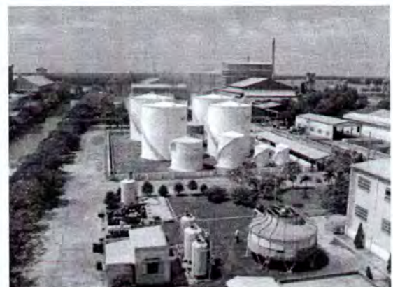
Nhà máy Super Phốt phát Long Thành
